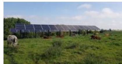
Figure 2 : Photographie du prototype installé dans le Minnesota (Etats-Unis)
