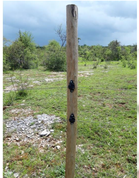
Figure 8 : Caractérisation des clôtures implantées dans l'emprise du parc solaire
